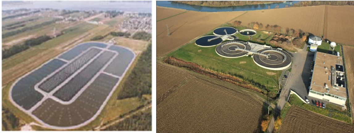
Figure I 3 : exemples des stations d'épuration-vue aérienne- (Lagunage, Boues activées)
