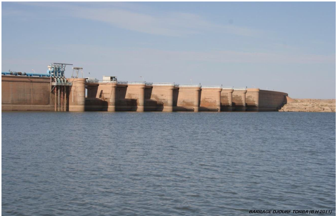
Figure I.3 : Le Barrage Djorf-Torba (évacué de crue) (ANBT, 2016).
