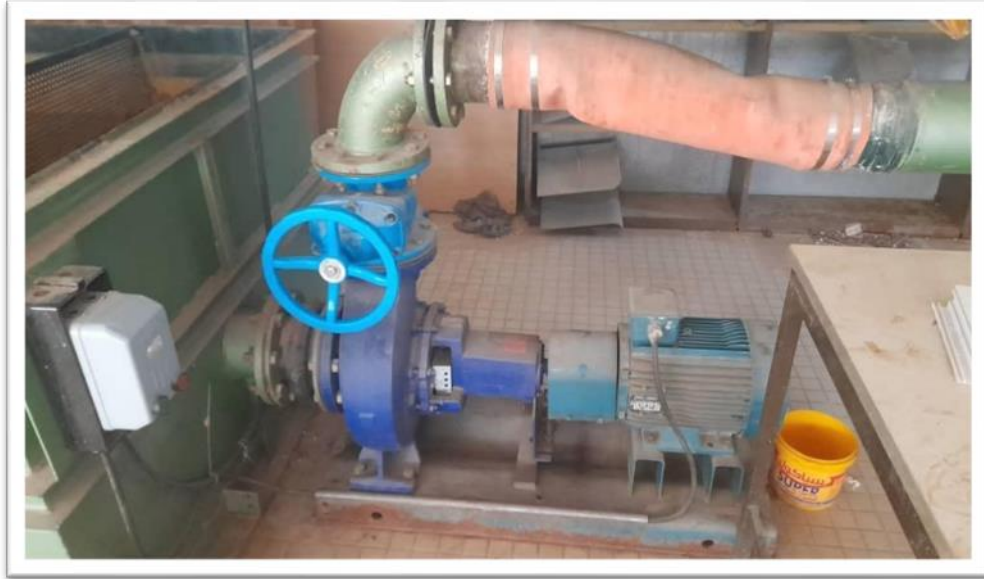
Figure III.2: La pompe utilisée pour générer le débit
