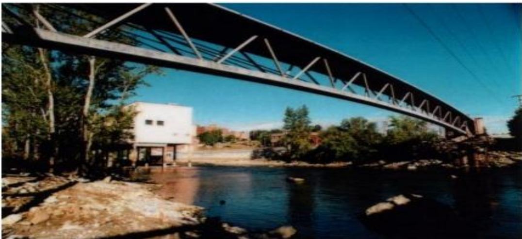
Figure 1.24: passerelle piétonnière SHERBROOKE au CANADA (Premier ouvrage au monde réalisé en Le béton à poudre réactive).
