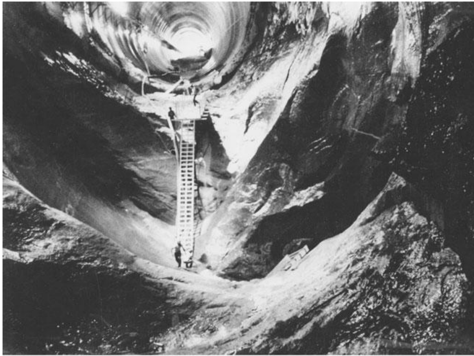
Figure 5.2 : les dommages par cavitation du revêtement en béton dans un tunnel de 12 pi (12,5 m) de diamètre du barrage de Glen Canyon. [4]
