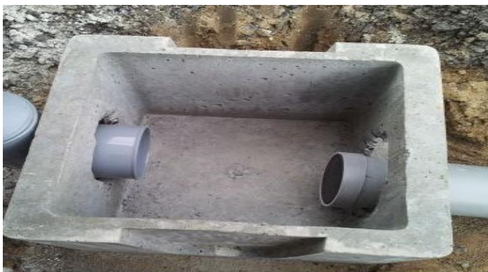
Figure V.4. Regard de chute
