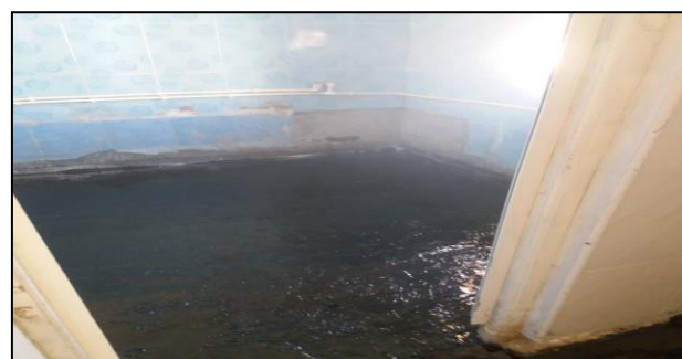
Figure IV.18: Réalisation de l'étanchéité à base de bitume.[8]
