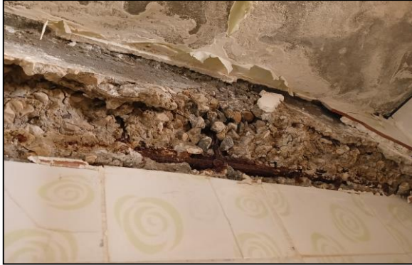
Figures III.3: Corrosion avancée des armatures au niveau des éléments en béton armé (niveau des Poutres et palies d'escaliers)
