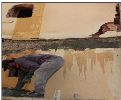
Figure IV.16: Enlever et gratter la rouille un brosse métallique et ragréage manuelle de poutre intérieur et extérieur de mortier de réparation en (SIKAMONOTOP SF126) .et (SIKAMONOTOP 4012)[8]
