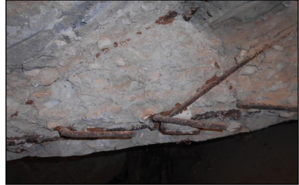
Figures III.3: Corrosion avancée des armatures au niveau des éléments en béton armé (niveau des Poutres et palies d'escaliers)
