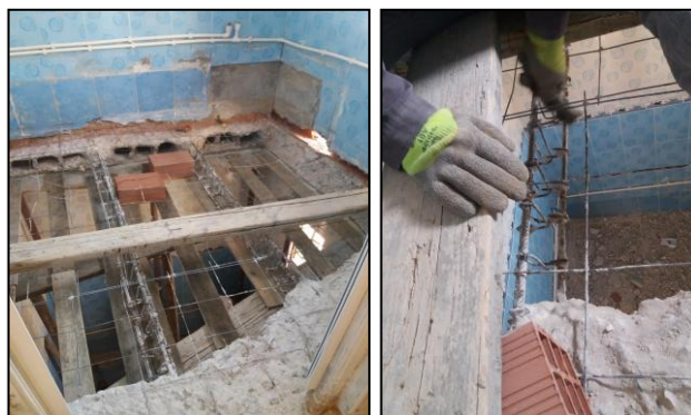
Figure IV.13: Démolition et Décapage du béton détérioré avec un bon nettoyage de l'armature de prose métallique(intérieur) [8]
