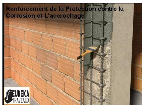
Figures IV. 6: Mise en place d'un passivant si nécessaire
