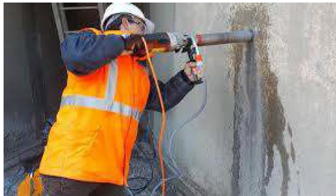
Figure II .5 : Carottage d'éléments en béton armé
