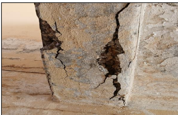
Figure III.6: Eclatements de l'enrobage au niveau des poutres
