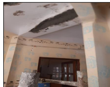
Figure IV.16: Enlever et gratter la rouille un brosse métallique et ragréage manuelle de poutre intérieur et extérieur de mortier de réparation en (SIKAMONOTOP SF126) .et (SIKAMONOTOP 4012)[8]
