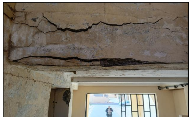
Figure III.6: Eclatements de l'enrobage au niveau des poutres
