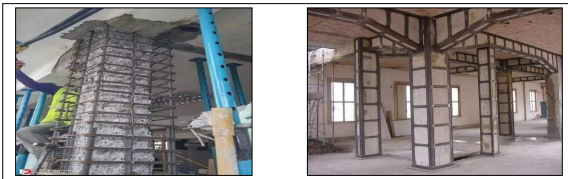
Figures IV.3 : L'image montre un poteau en béton armé en cours de chemisage
