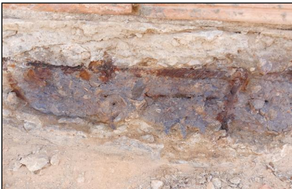
Figures III.14 : Migration de chlorure, précipitation visible blanc de chlorure d'argent
