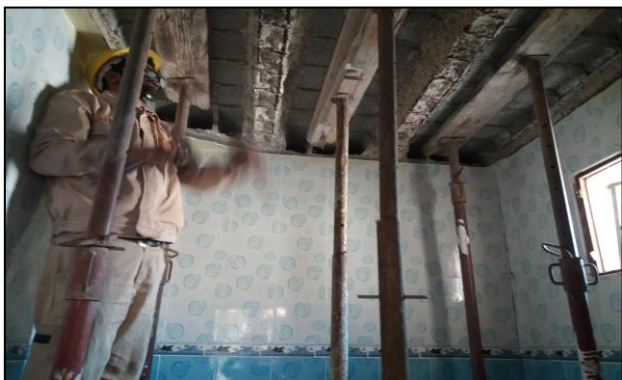
Figure IV.12: Consiste à renforcer la dalle endommagée pour plus de sécurité[8]
