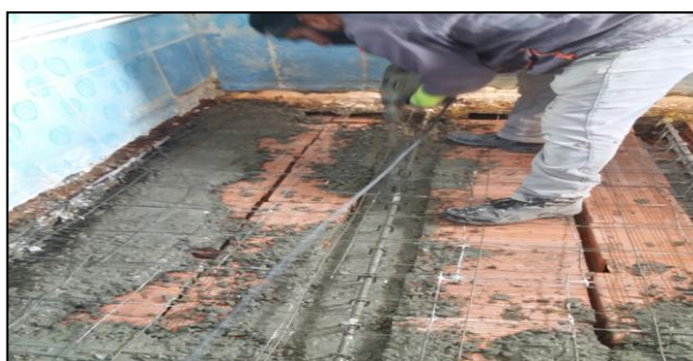
Figure IV.17: Remoulage et coulage le dalle et élément structurelle à l'aide d'un vibreur.[8]
