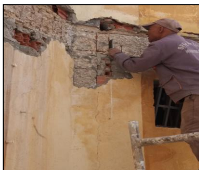
Figure IV.16: Enlever et gratter la rouille un brosse métallique et ragréage manuelle de poutre intérieur et extérieur de mortier de réparation en (SIKAMONOTOP SF126) .et (SIKAMONOTOP 4012)[8]
