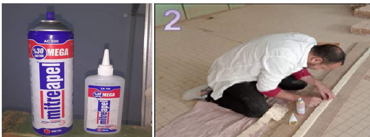
Photo I.11 : - 1. Adhésif Mitreapel utilisé pour la fixation | 2. Application de l'adhésif sur le tapis rugueux.
