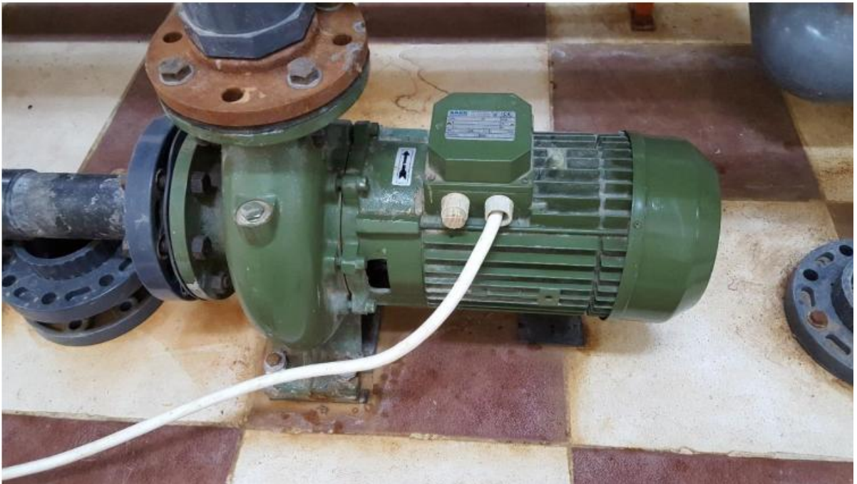
Photo III.1 : Pompe centrifuge axiale (pompe principale).
