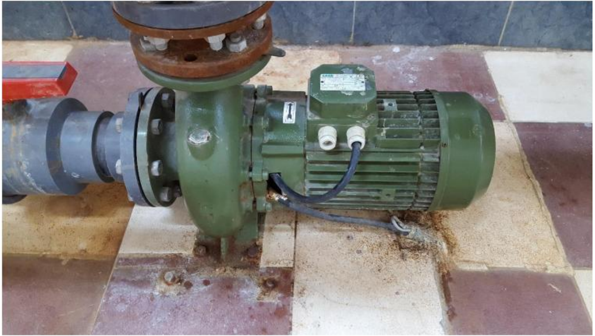
Photo III.1 : Pompe centrifuge axiale (pompe principale).
