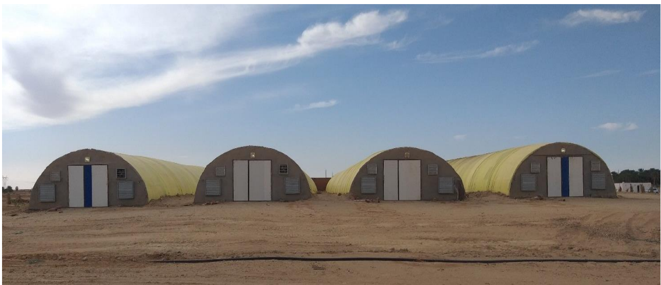
Figure 01 : Bâtiments d'élevage Avicole à El-Oued (Photo originale, 2023)
