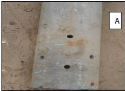
(a) Conduite d'amiante ciment utilisée dans le réseau de
