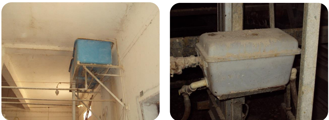
Figure 40 : System de distribution d'eau (Originale)
