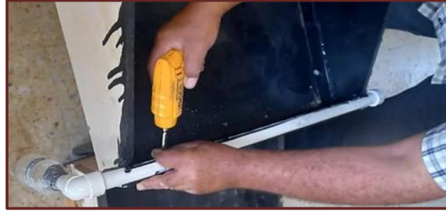
الشكل (III-5): تثبيت انبوب تجميع المياه.
