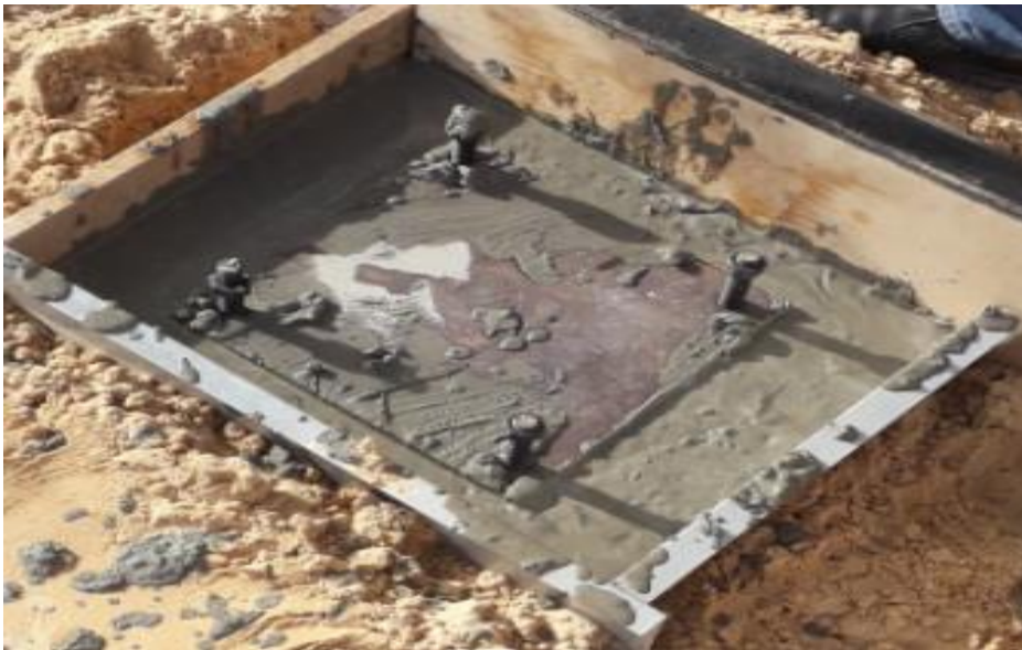
الشكل 1.V قاعدة خرسانية لتثبيت الهيكل المعدني
