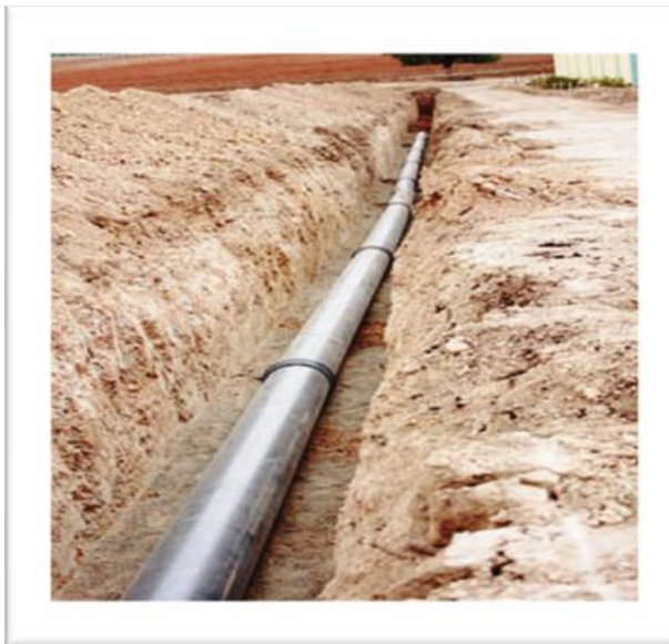
Photo VII.3 Pose des canalisations en tranchée (internet)
