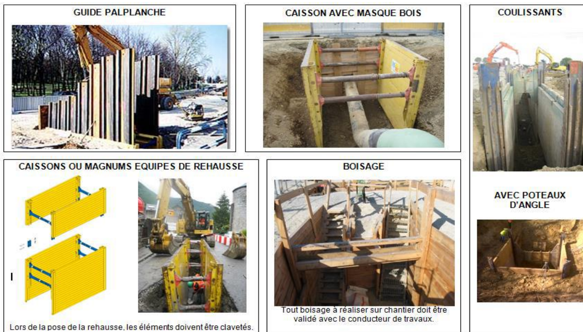
Photo VII.1-Blindage des tranchées avec la mise en place de la conduite et le regard (internet)
