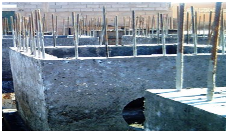
Photo VII.4 Réalisation du regard ( B.E.H Sahara )
