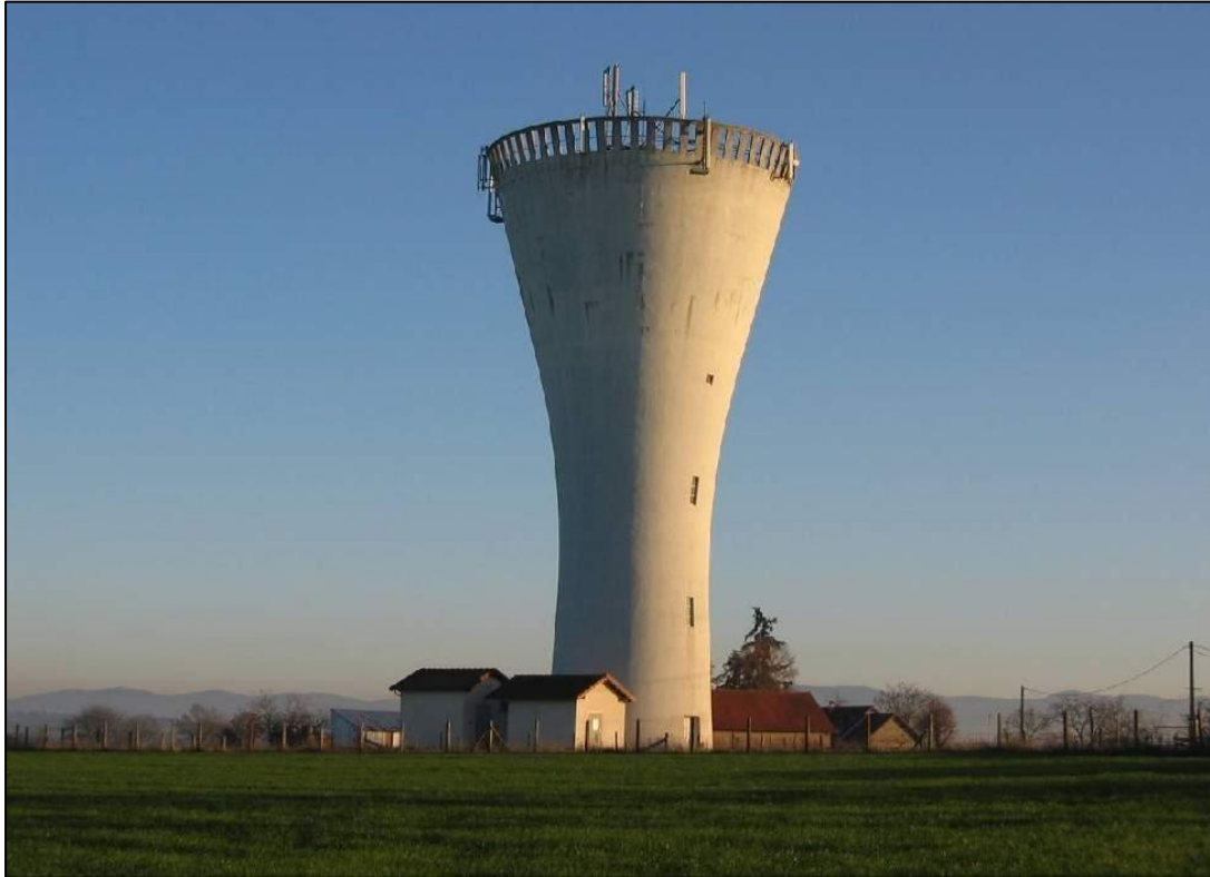
Figure 14 : Réservoir surélève
