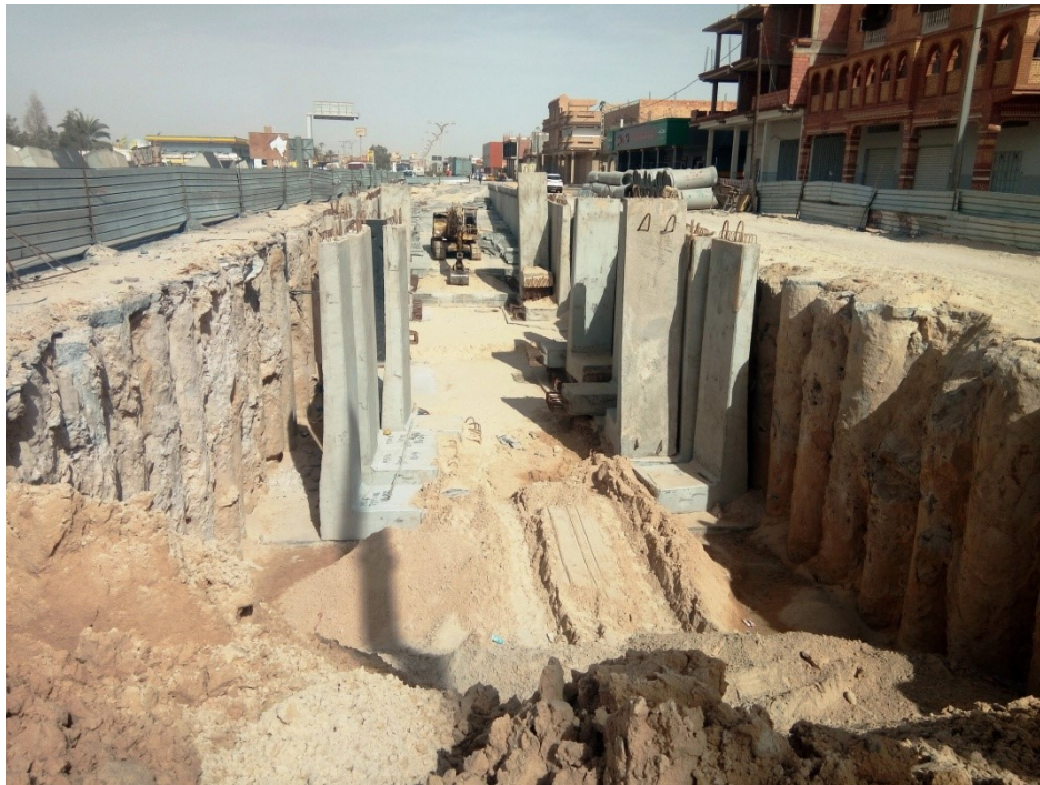
Figure 4.4 : Vue de l'ouvrage en cours de la réalisation
