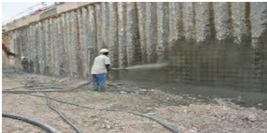
Figure 0.4 : Soutènement par pieux espacés
