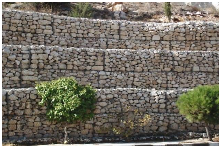
Figure 0.3 : Mur en gabions
