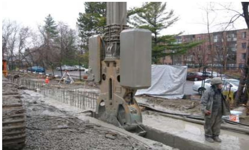
Figure 0.7 : Soutènement par paroi moulée
