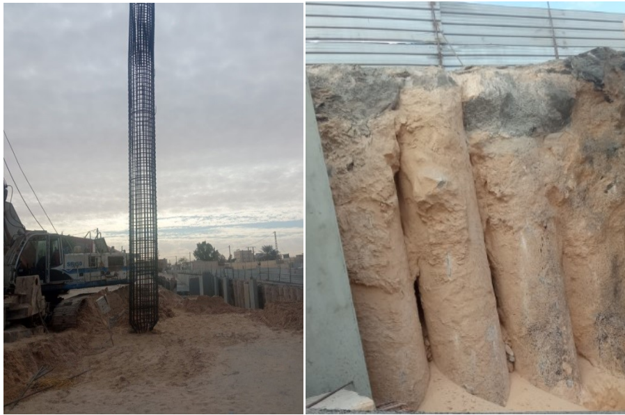
Figure 4.2 : Pieux de l'ouvrage
