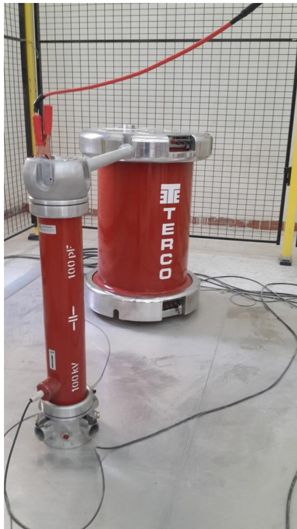
Figure III.2 : Transformateur à haute tension utilisé pour l'essai.
