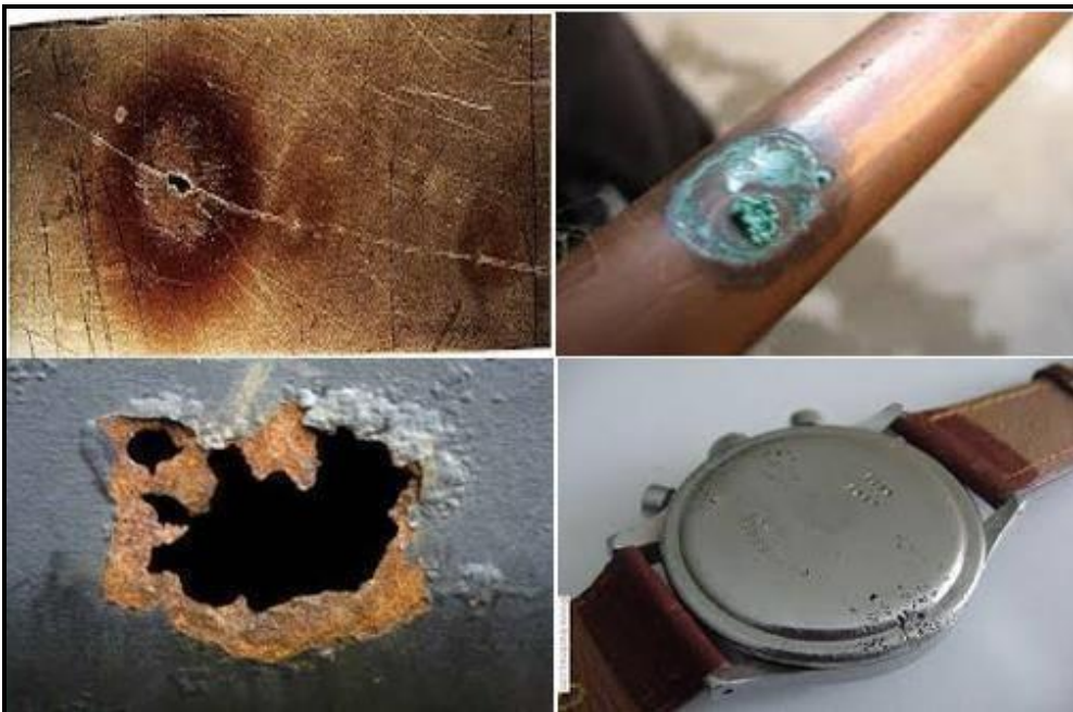
Figure III.2: Quelques exemples de corrosion par piqûres.
