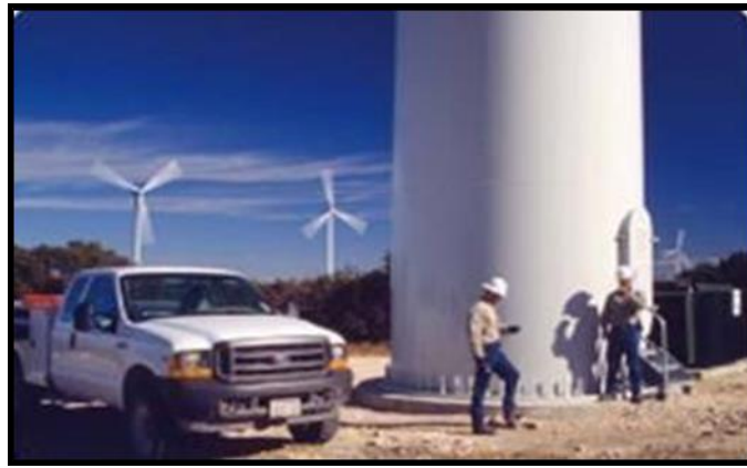
Figure II. 4: Tour d'une turbine
