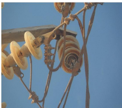
d- Pylône implante près du sol en l'argile (usine de briquetterie)
