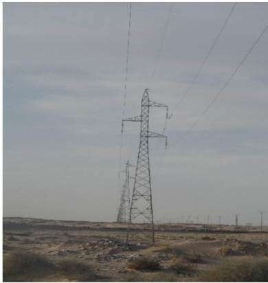
a-Pylône implante dans le sable
