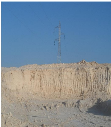
c- Pylône implante près du sol en tuf
