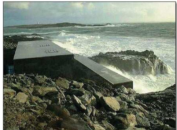
Figure II.5 turbine de l'IMPET 500 Figure II.6 massif en béton comprenant la colonne et la centrale
