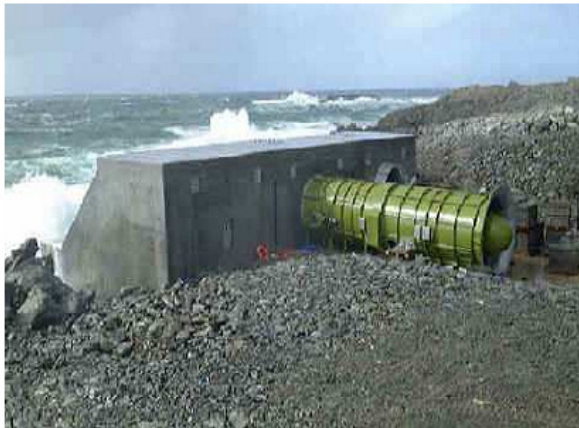
Figure II.5 turbine de l'IMPET 500 Figure II.6 massif en béton comprenant la colonne et la centrale
