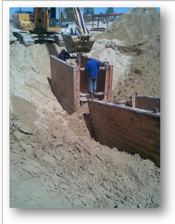
Figure.22 : La protection contre les éboulements (Blindage).
