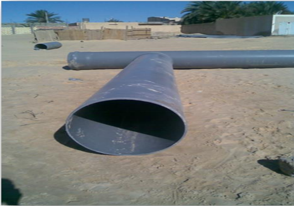
Figure.24 : Pose des canalisations (PVC).
