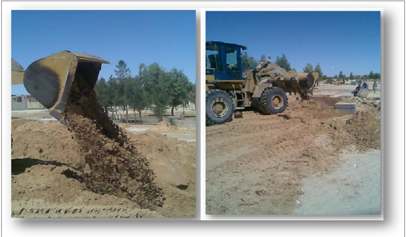
Figure 25 : Remblaiement des tranchées.
