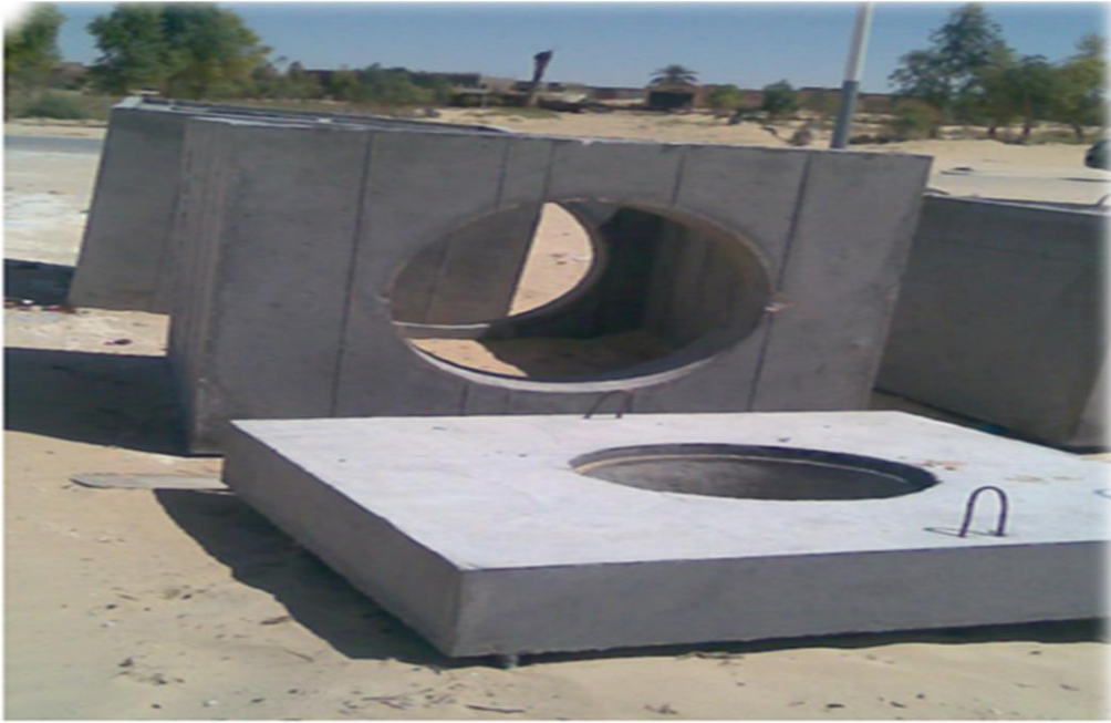
Figure.26 : Construction des ouvrages surplace.
