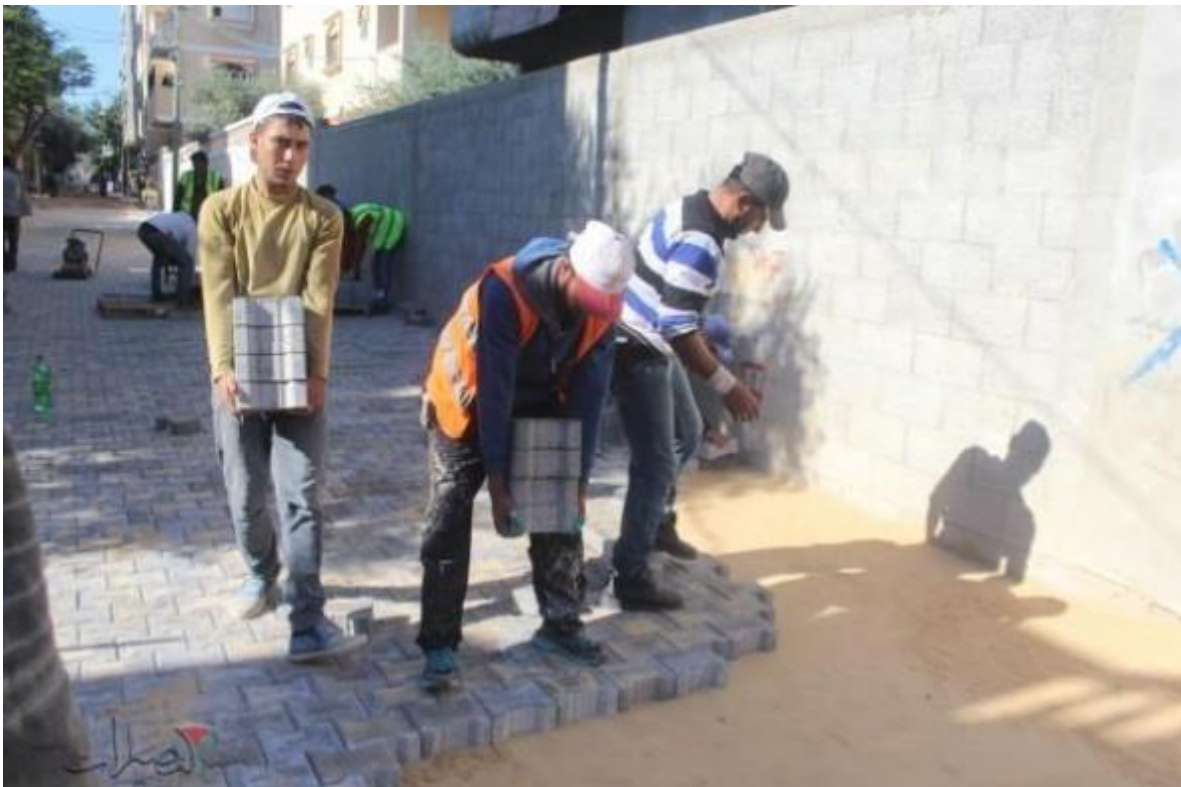
Photo 08: Image montre le pavage des rues et des ruelles étroites de la ville
