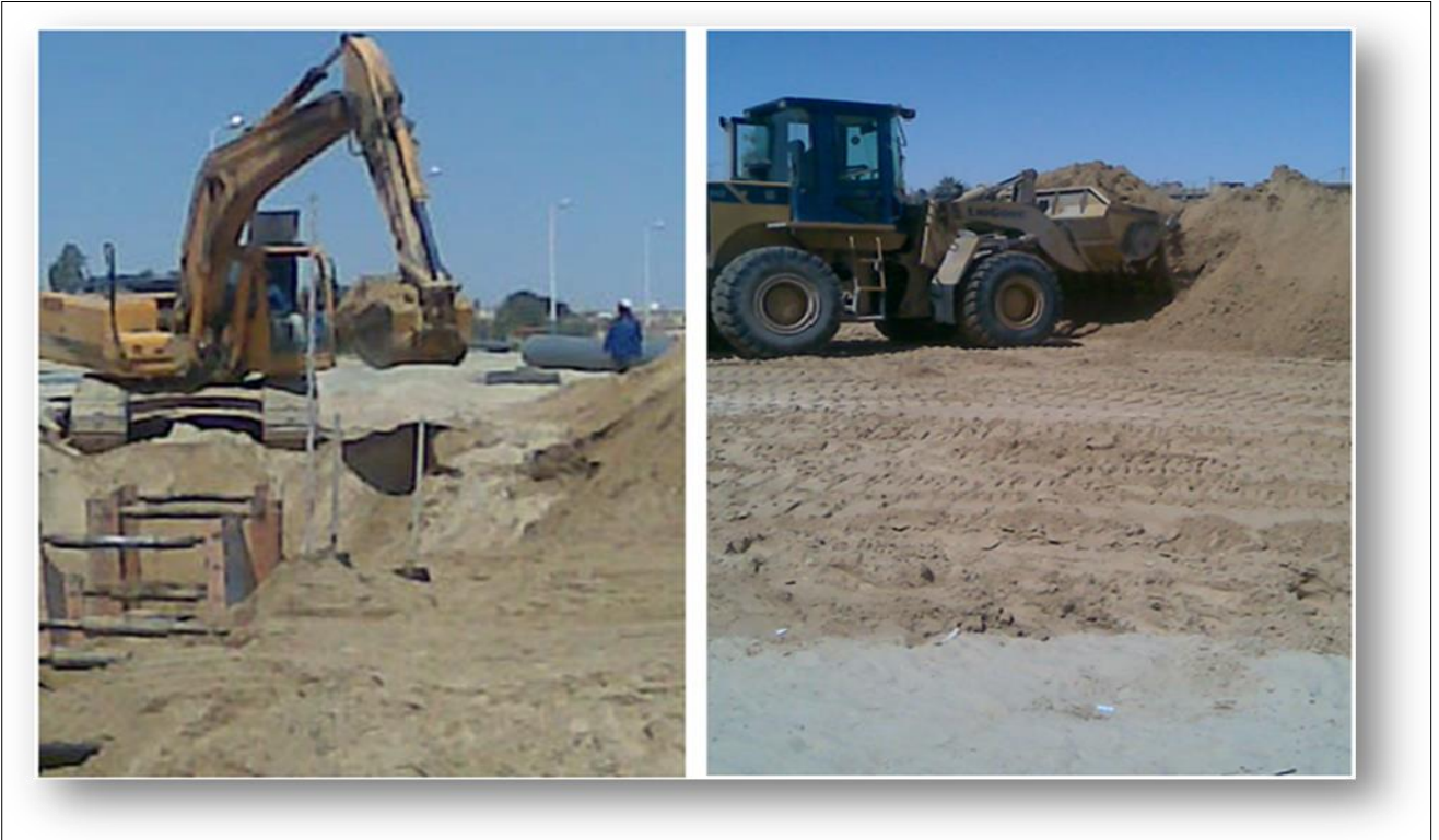
Figure.23 : Exécution et terrassement des tranchées.
