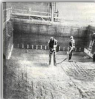
Figure I.5. Réalisation d'une piscine. [19]
