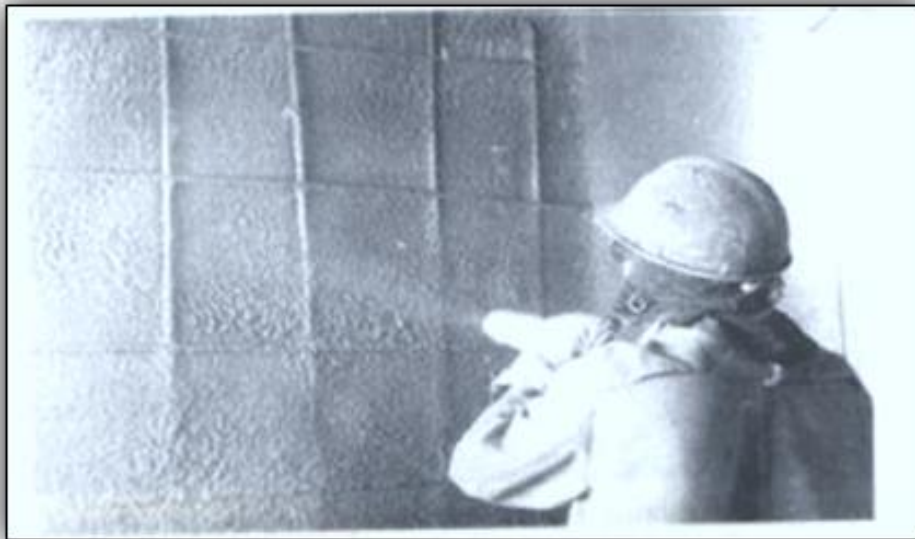
Figure I.4. Le béton de sable peut être utilisé pour la projection sur des surfaces anciennes. [19]
