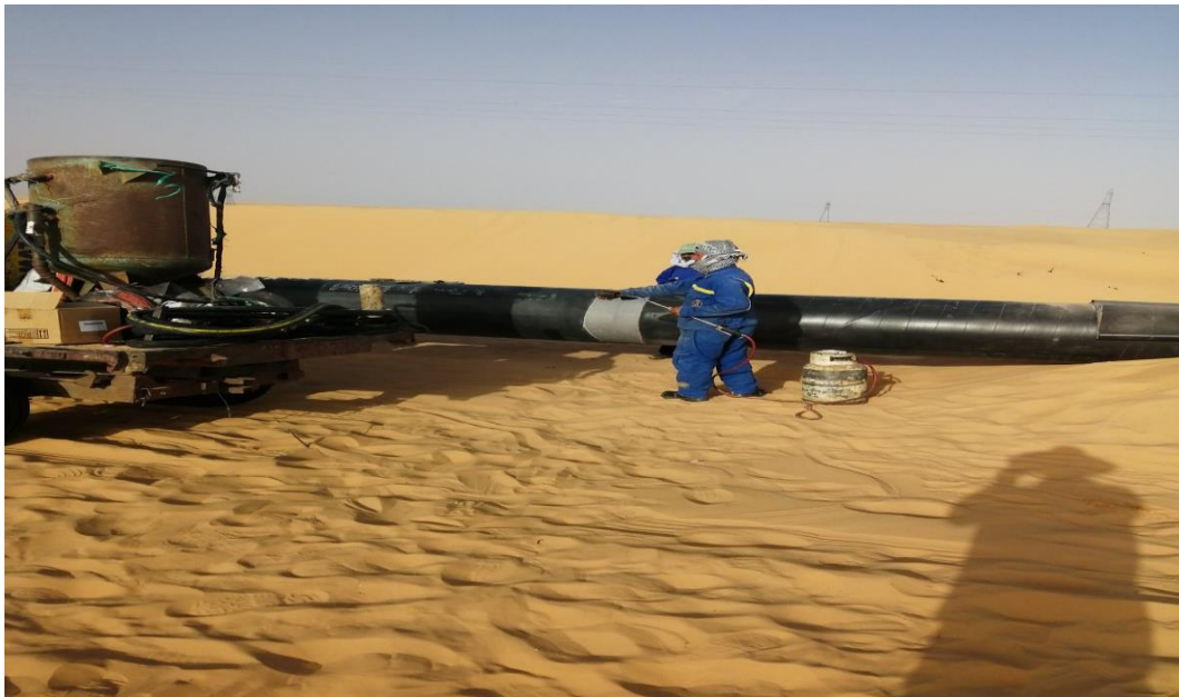
Figure III.6 : Revêtement (Gazoduc Djamaa-Touggourt)
