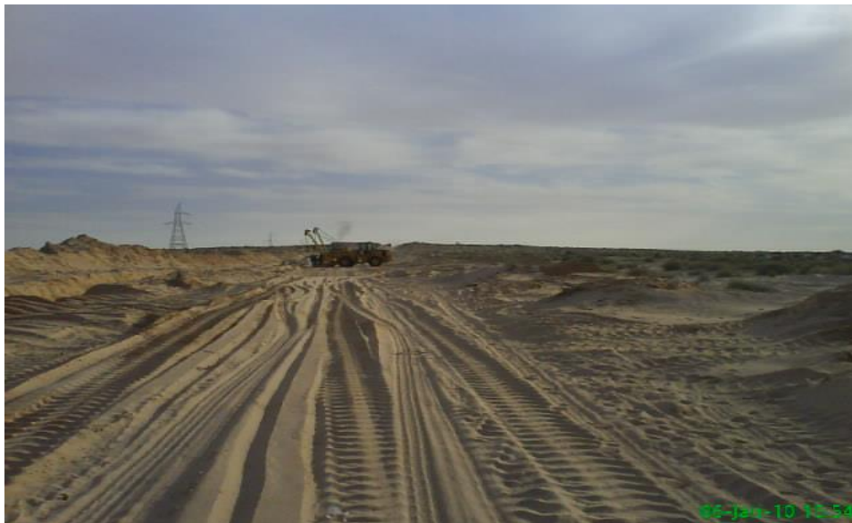
Figure III.2 : Ouverture de piste (Gazoduc Djamaa-Touggourt)
