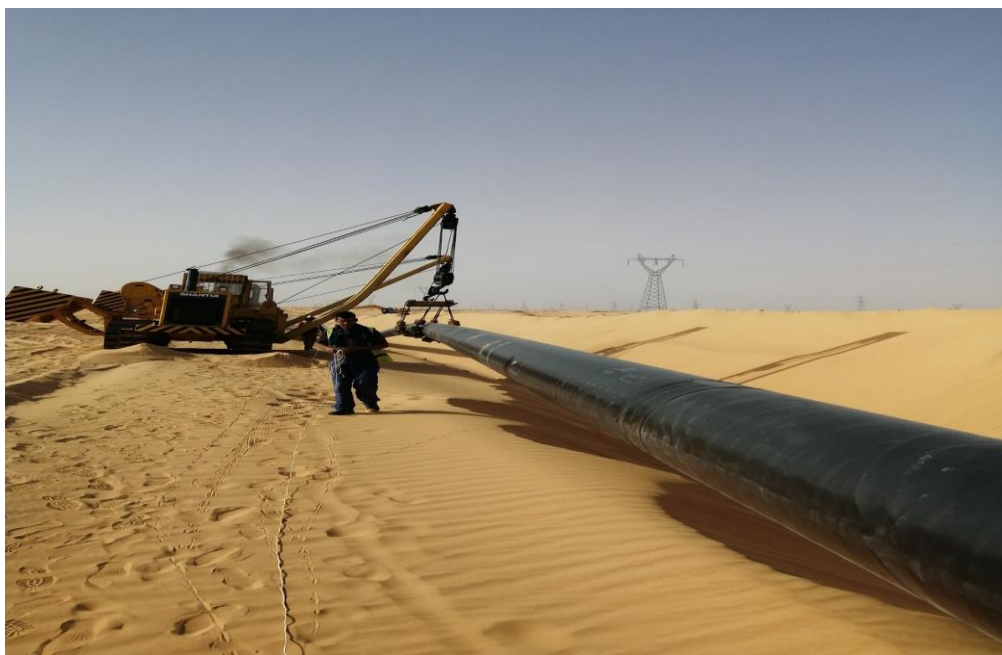
Figure III.7 : Mise en fouille (Gazoduc Djamaa-Touggourt)
