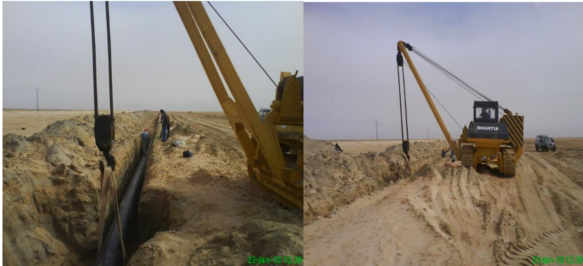
Figure III.8 : Mise en fouille et Remblai (Gazoduc Djamaa-Touggourt)
