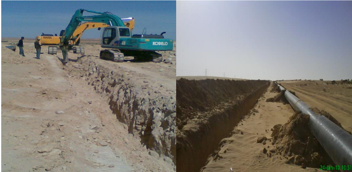
Figure III.4 : Ouverture de la tranchée (Gazoduc Djamaa-Touggourt)
