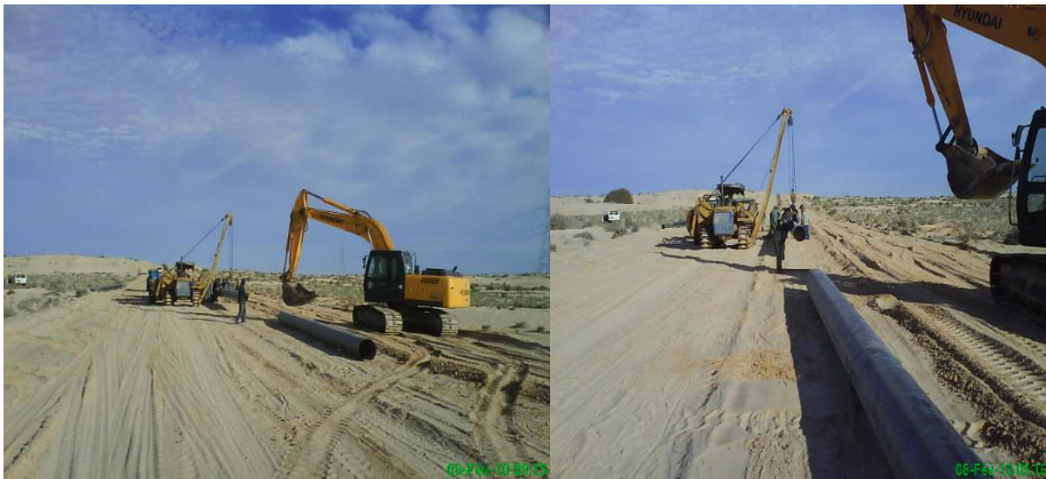
Figure III.3 : Bardage et pré alignement (Gazoduc Djamaa-Touggourt)
