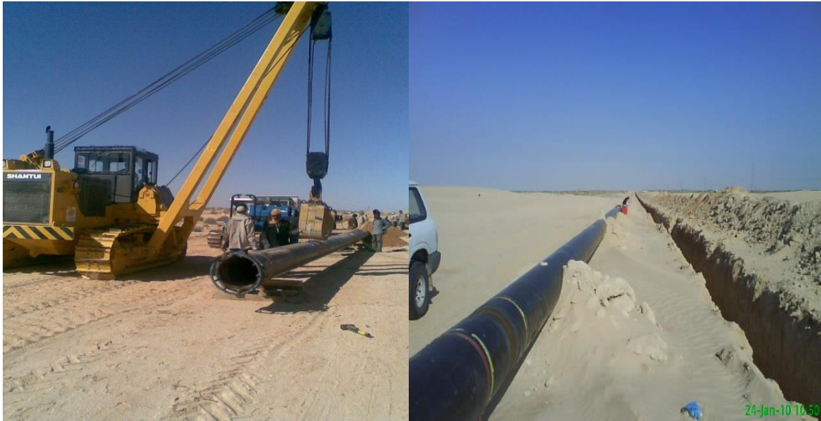
Figure III.5 : Soudure en ligne (Gazoduc Djamaa-Touggourt)
