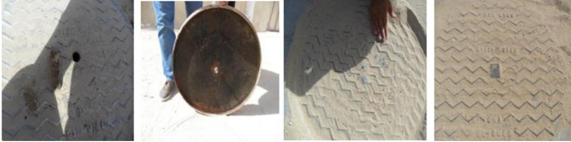
PHOTO II.5 : Fermeture des trous des regards
