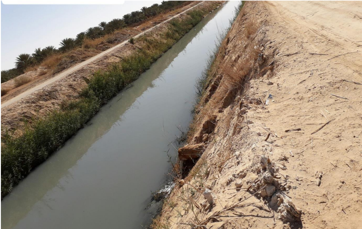
photo(II.1): Canal principal d'oued Righ dans la région sud(Bouaichi-Ben.A.Allah)
