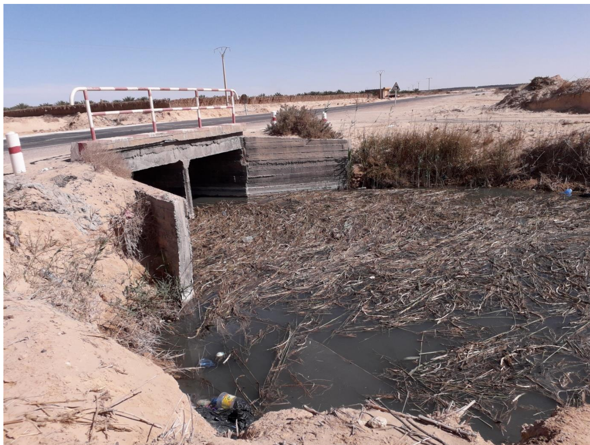
Photo(IV.3) : le problème du curage dans le station Ranou(Bouaichi et B.A.Allah 2019)
