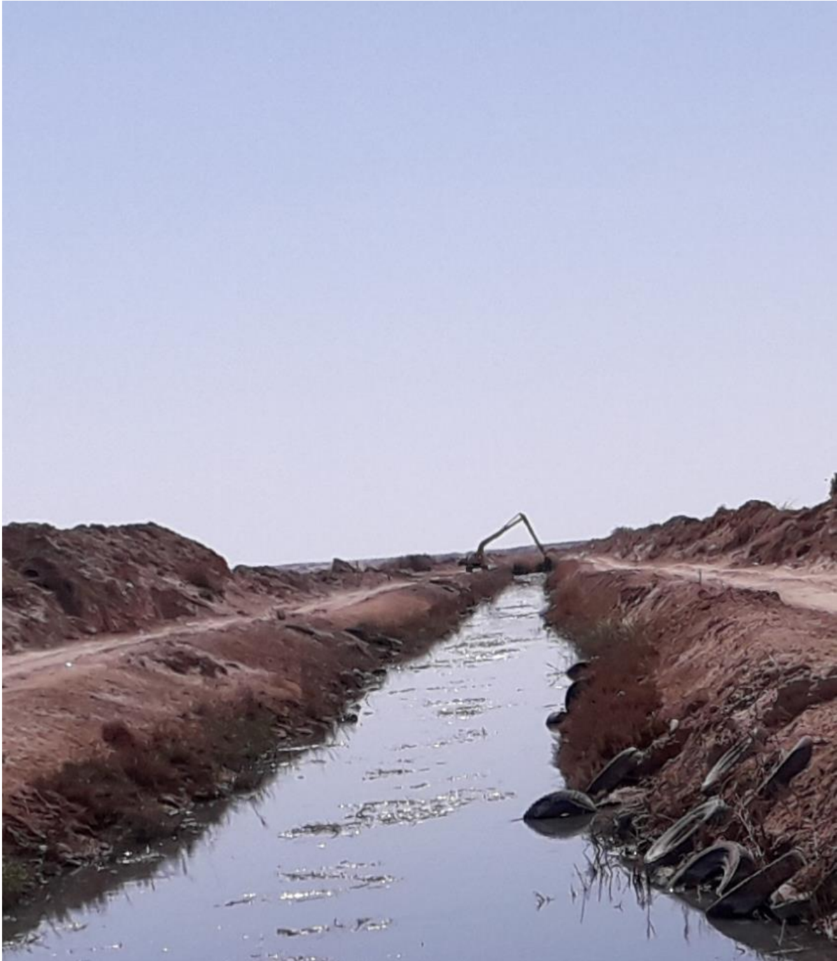
Photo(IV.4) : Opérations du curage station Ranou(Bouaichi et B.A.Allah 2019)
