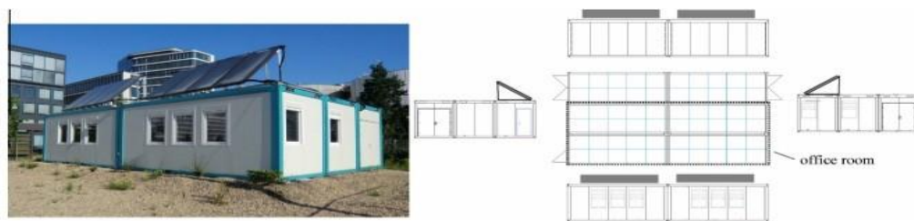
Figure I.6 : Installation pilote d'un système de climatisation assistée par desséchant à Hambourg, Germany.
