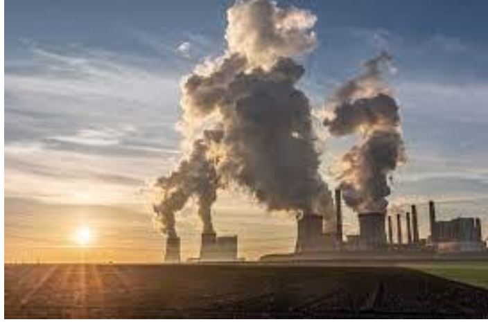
الصورة 4: محطات معالجة ثاني أكسيد الكربون [5]
