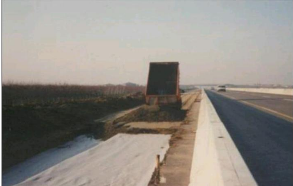
Figure 1.16: Un géosynthétique dans une construction routière
