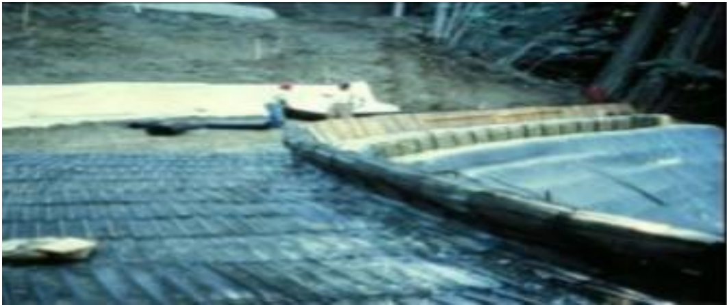
Figure 1.17: un renforcement d'une pente par un géosynthétique [9]
