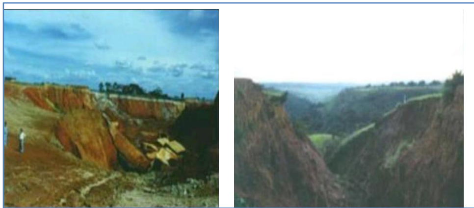
Figure 1.22 : à gauche contrôle d'érosion sur pente, à droite travaux achevés[7].
