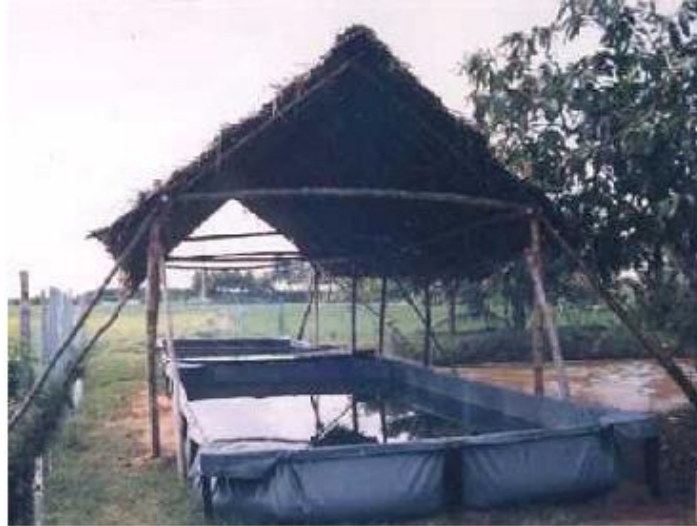
Figure6 : Bassin en tissu polyamide enduit PVC, Ecopark, Madurai, Tamil Nadu (Inde), 18 m 2 , 1998 ( Jourdan, 1999).
