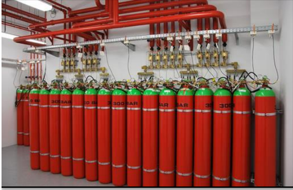
شكل رقم (9- II) يوضح صورة لأنظمة رش الغاز الثابتة
