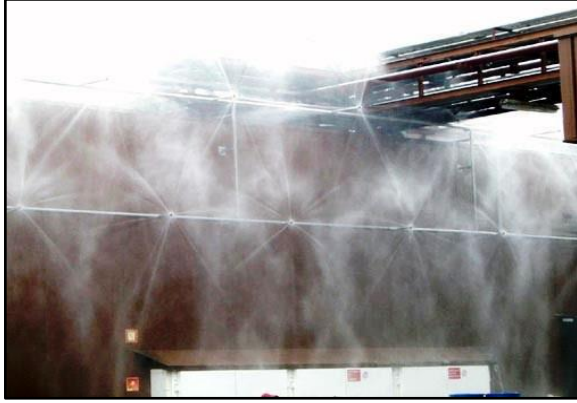
شكل رقم (10- II) يوضح صورة نظام حماية المياه الآلي
