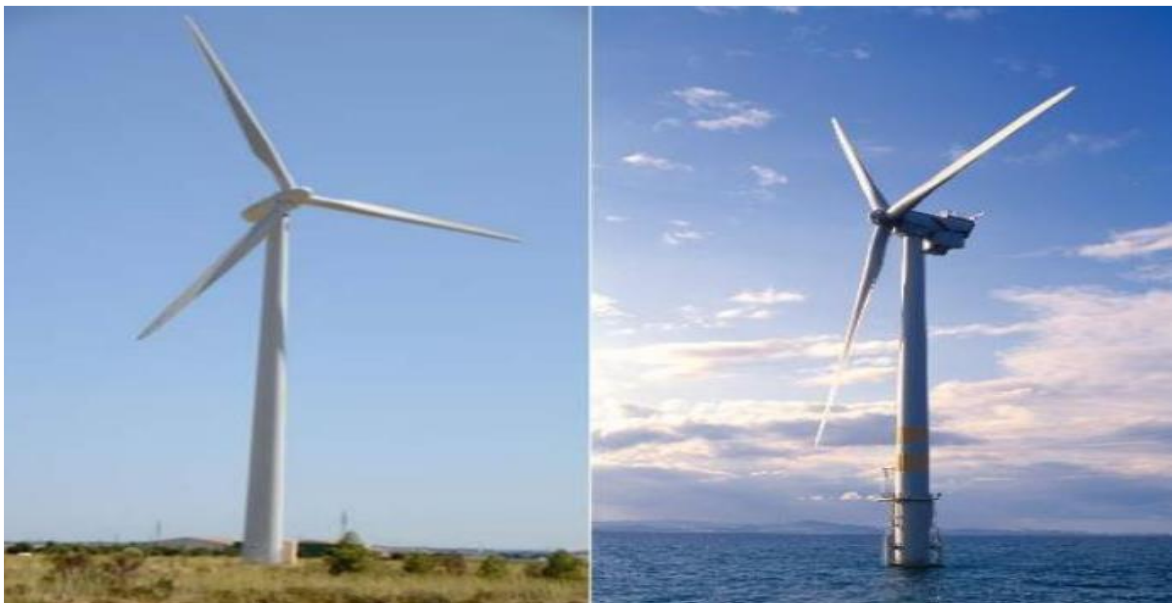
Fig1.2: Eoliennes à axe horizontales
