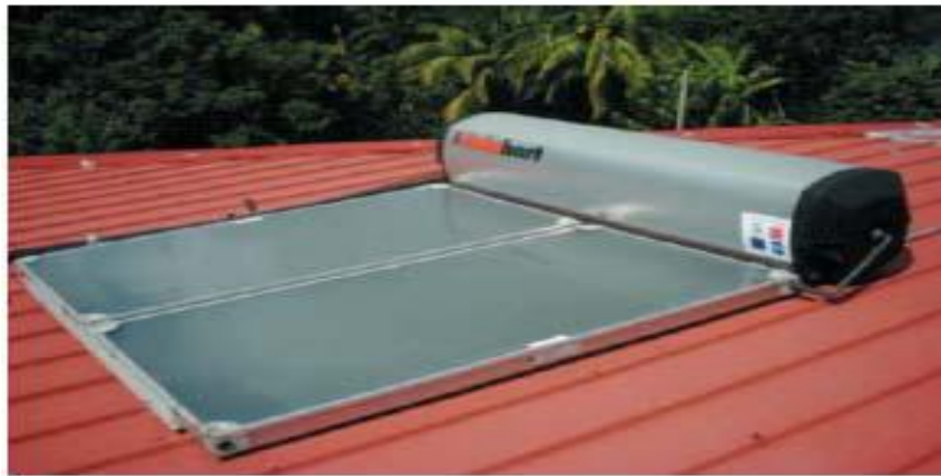
Figure I.5 : Chauffe-eau thermosiphon monobloc (chauffage de l'eau).
