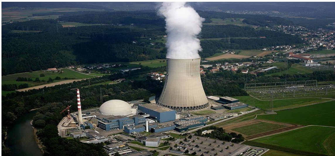
Fig. II.5 : Photo d'une tour de refroidissement dans une centrale thermique d'Europe.
