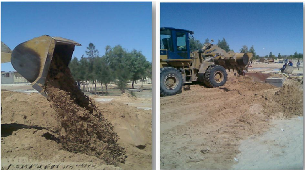
Photo VI -3 : Remblaiement des tranchées.
