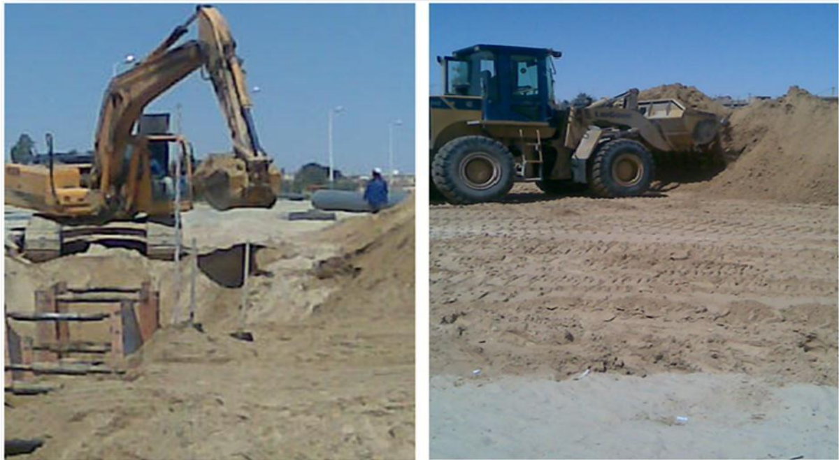
Photo VI -2 : Terrassement des tranchées.
