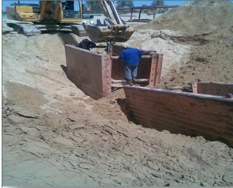
Photo VI -1 : La protection contre les éboulements.
