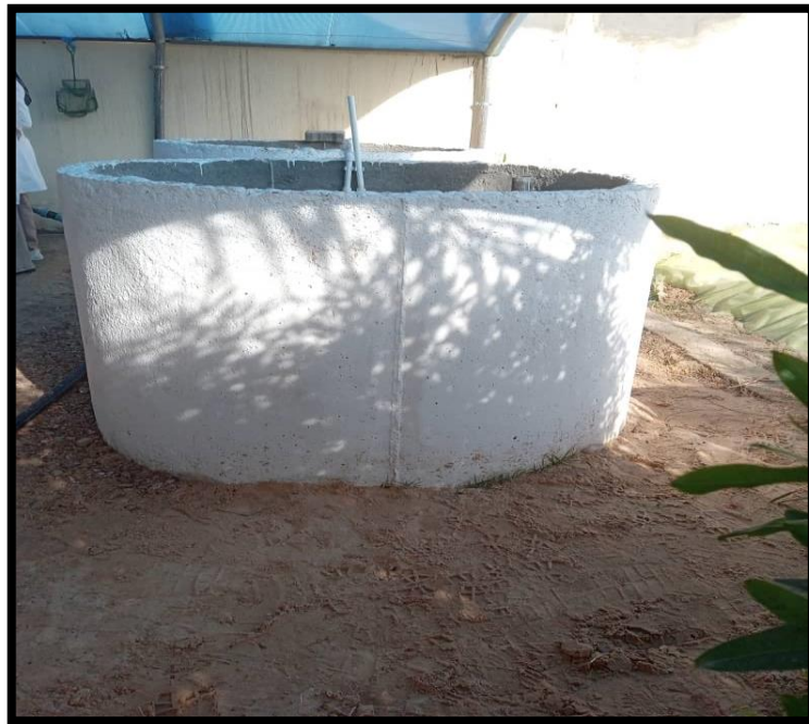
Figure .22. Modèle de bassin en Béton.
