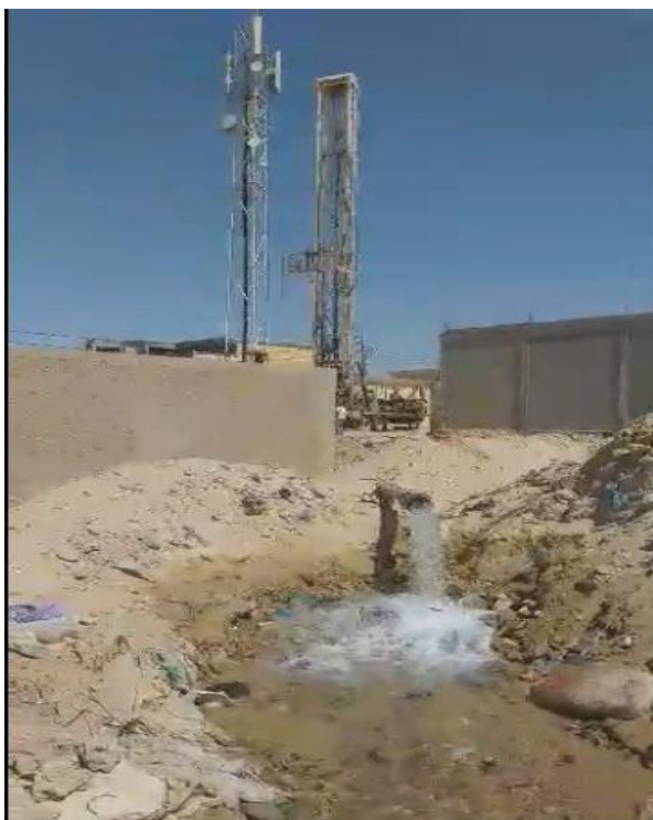
Photo IV.01: Forage de remplacement Beb Elgharbi.
