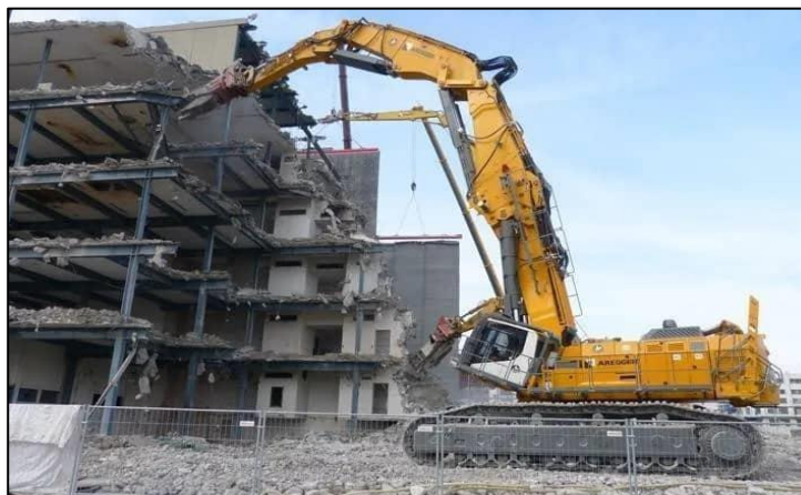
Figure I.8. Déchets de démolition
