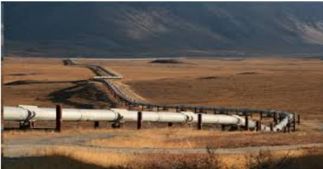
Figure 2. Pipelines pour transport d'hydrocarbure [19]
