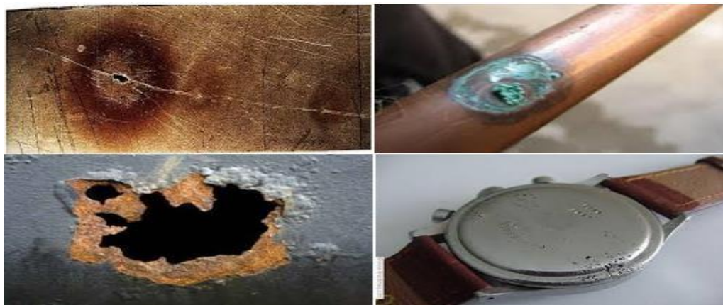
Figure 9 : Quelques exemples de corrosion par piqûres. Perforations sur la surface [04]
