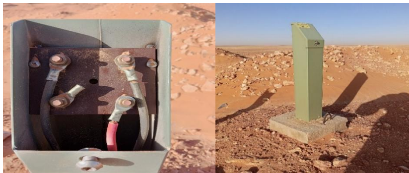
Figure 47 : Borne de balisage (poste de contrôle)
