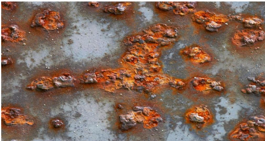
Figure 11 : Photo de la corrosion inter granulaire. Précipitation de carbures dans les joints de grain [21]
