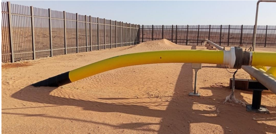
Figure 43 Départs la ligne de puits vers unité de traitement
