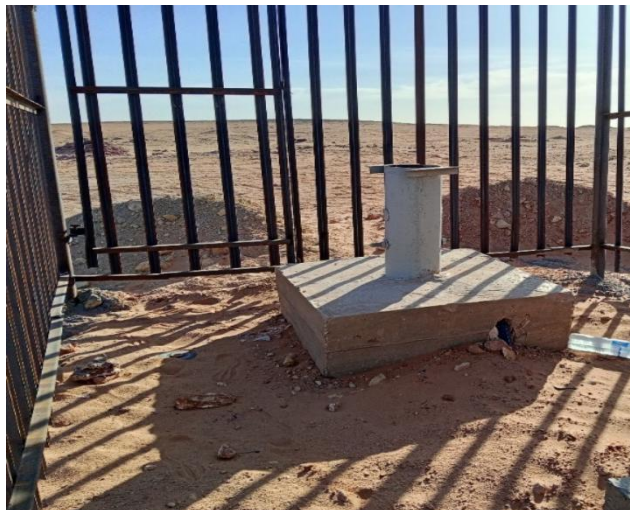
Figure 46 puits anodique
