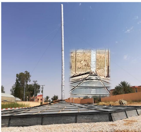
Fig. (V.8) : schéma de la jonction droite dans la région de transition collecteur-cheminée.
