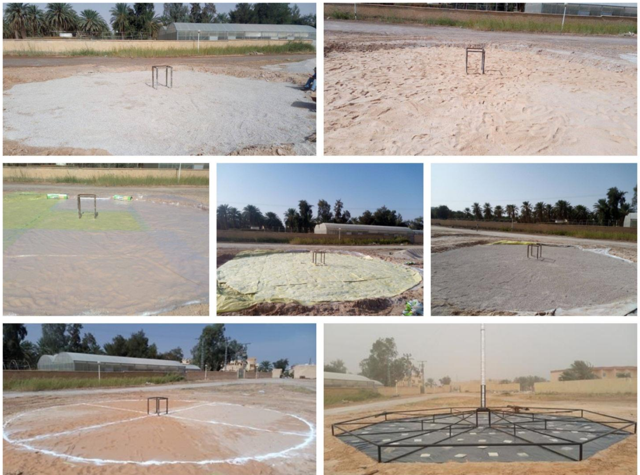
Fig. (V.11) : Les étapes d'isolation thermique du sol de la cheminée solaire (gravier épais, sable, plastique, folio en aluminium avec laine de verre, gravier, sable, plastique noir).
