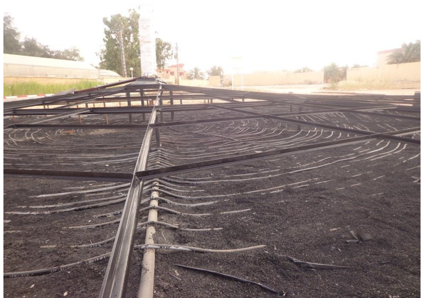
Fig. (V.6) : Construction de la zone du collecteur de cheminée solaire
