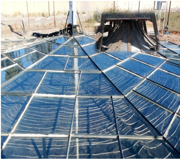
Fig. (V.7) : schéma de la jonction incurvée dans la région de transition collecteur-cheminée.
