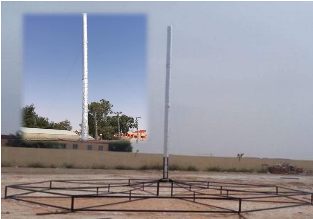
Fig. (V.2) : Photo de la cheminée.
