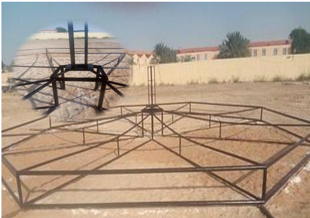
Fig. (V.3) : Structure métallique de la cheminée.
