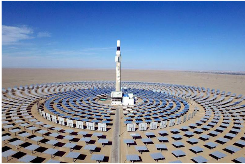
Fig. (I.5) : Centrale solaire à tour
