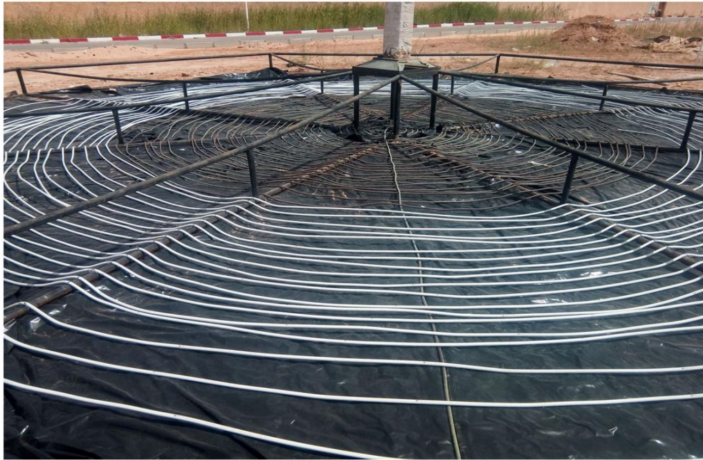
Fig. (V.13) : Image montrant l'échangeur thermique en spirale
