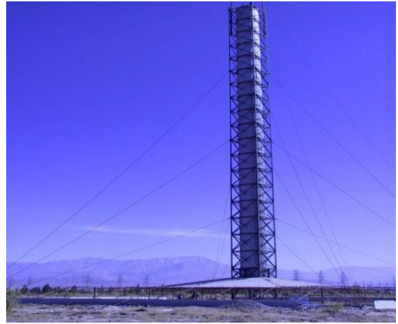
Fig. (II.8) : Photo de la centrale à cheminée solaire pilote de Kerman en Iran
