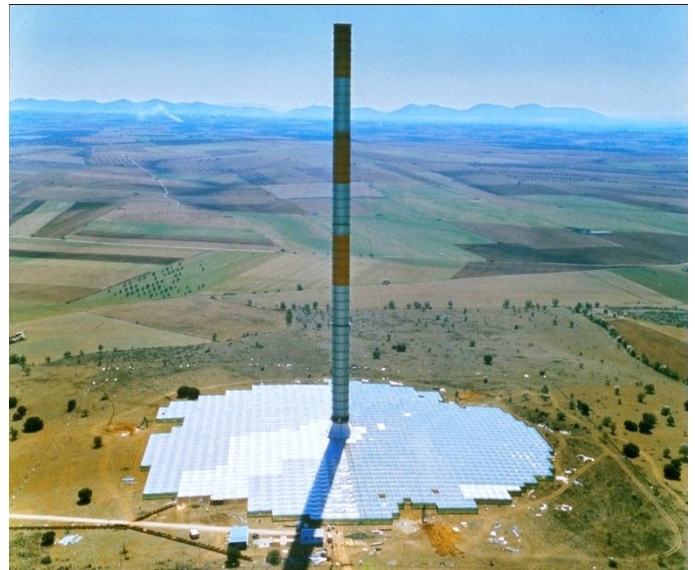
Fig. (II.6) : Photo des différents compartiments de la centrale à cheminée solaire de Manzanares
