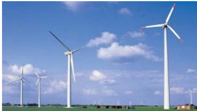
Fig. I-5 : Éoliennes à axes horizontales.
