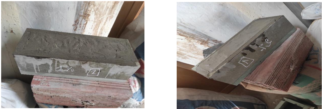
Figure 8 : Remplissage des moules.
