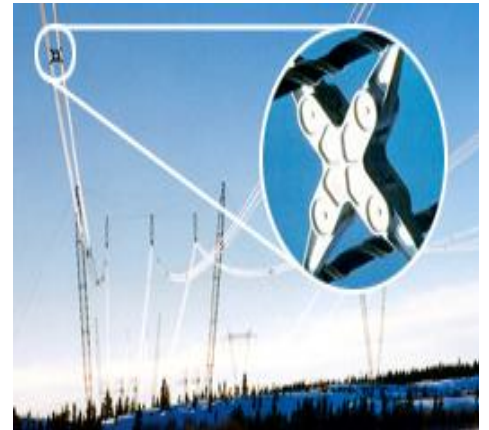
Figure (I.11): Entretoise d'un faisceau de conducteurs
