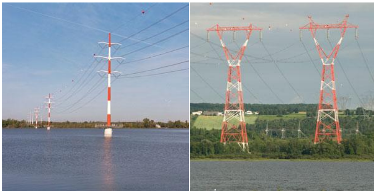
Figure (I.8): Pylône de traversée
