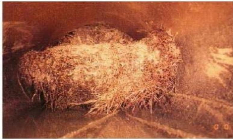
Figure I.11 : Exemple de blocage provoqué par la présence de racines.
