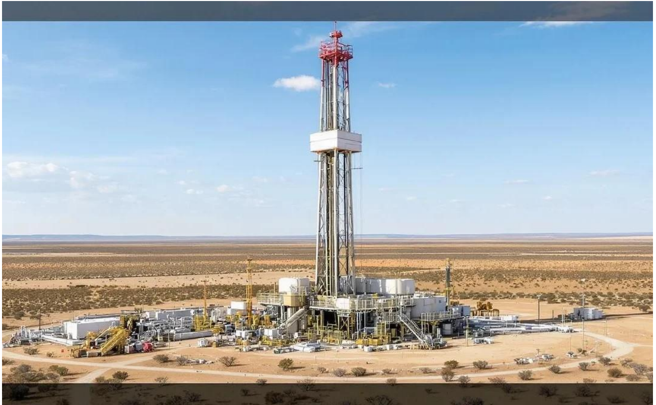
الشكل (5.1): منصة حفر عمودية تستخدم لاستخراج الغاز الطبيعي
