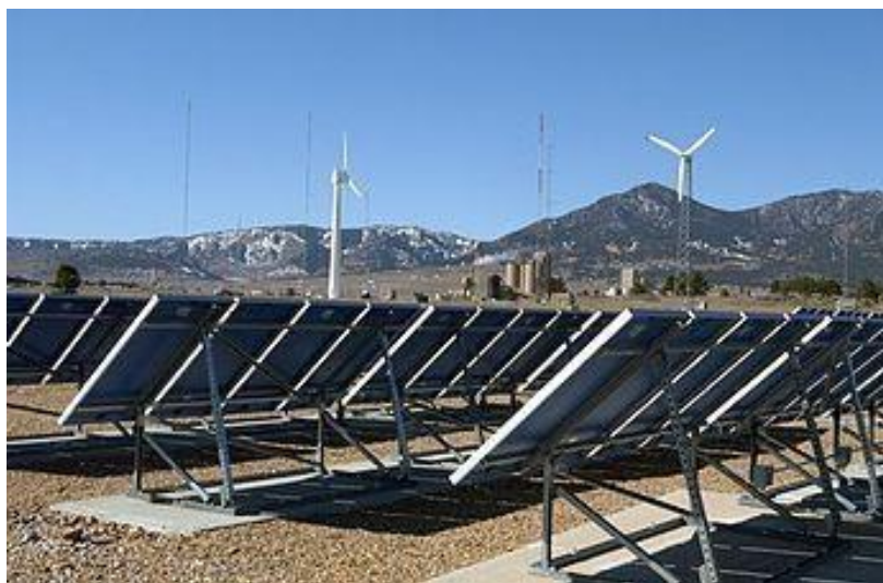
Figure I. 11 : Exemple d'un système photovoltaïque hybride.
