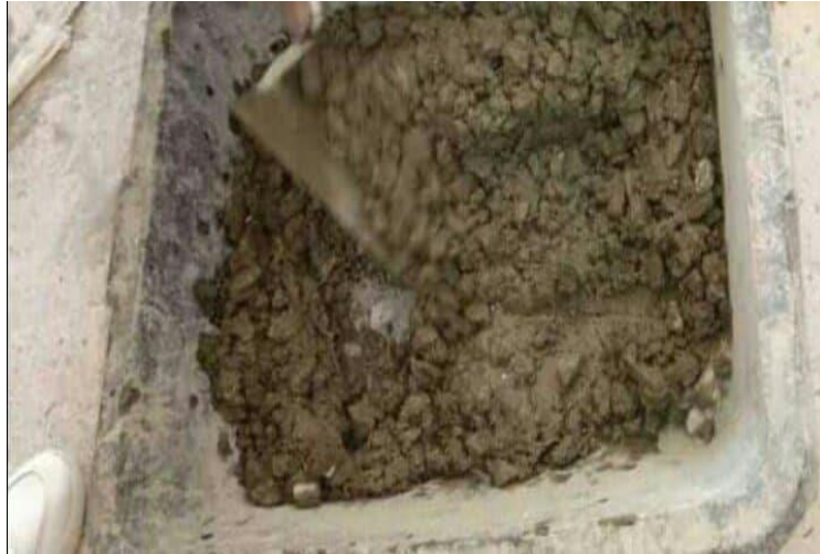
Figure 6 : Malaxage de béton.
