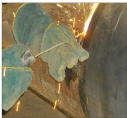
Fig. 2. Assemblage de deux tubes d'acier X42 avec le procédé de soudage à l'arc avec électrodes enrobées (SMAW) (10).
