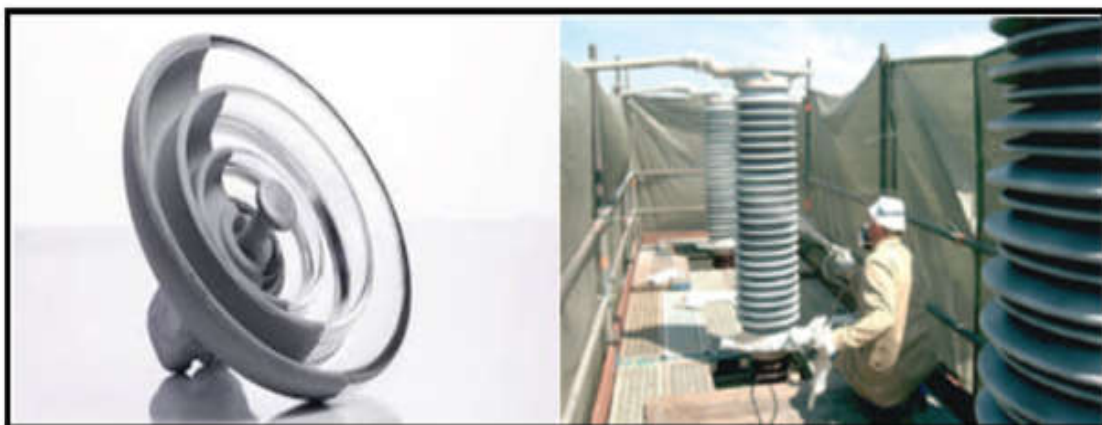
Figure I.10: Revêtement silicone d'isolateur
