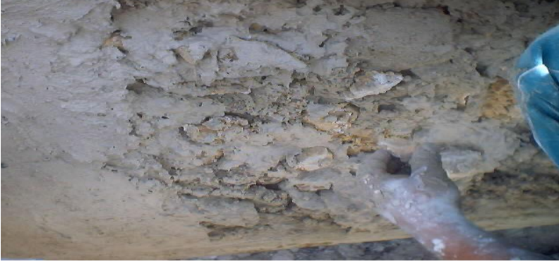
عملية التنظيف الشقوق و إزالة الطبقات المتآكلة
