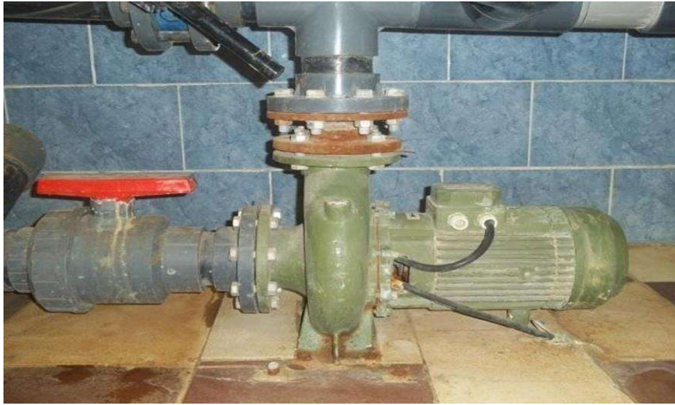
Photo. 4.2 : Pompe centrifuge axiale
